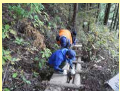
板を張る補修作業
