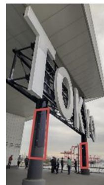
柱に設置した Airソーラー
