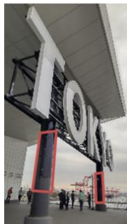
柱に設置した Airソーラー
