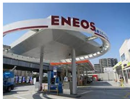
<都関連用地を活用した水素ステーション (Dr.Driveセルフ潮見公園店)>
