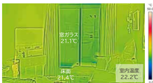
東側外壁及び窓面のサーモ画像（12 月下旬 12:00）
