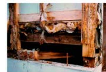
●内部結露により躯体が腐朽した例
