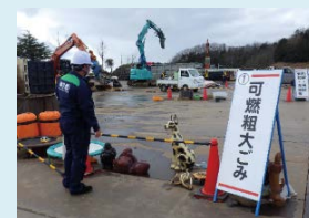
片付けごみ仮置場の設置
