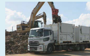
災害廃棄物の積み込み
