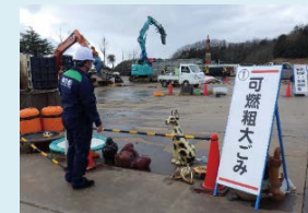
片付けごみ仮置場の設置
