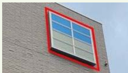
< 建材一体型太陽光発電設備 (奥多摩水と緑のふれあい館) >
