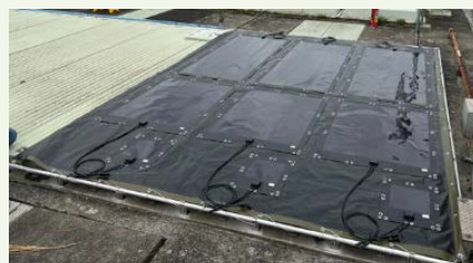
< 次世代型ソーラーセル (森ヶ崎水再生センター) >
