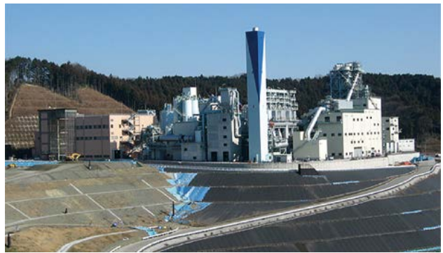
エコセメント施設の全景 提供：東京たま広域資源循環組合
