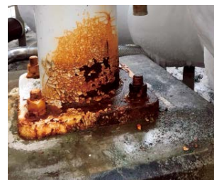
経年劣化した高圧ガス施設の一例
