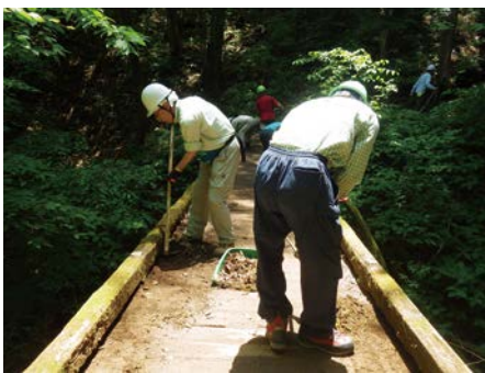
多摩地区での歩道整備 （堆積土砂の掻き出し）
