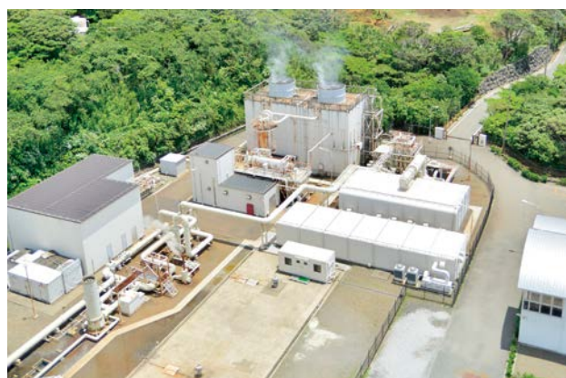
八丈島地熱発電所
