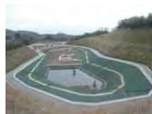
大島一般廃棄物管理型最終処分場の全景 提供：東京都島嶼町村一部事務組合
