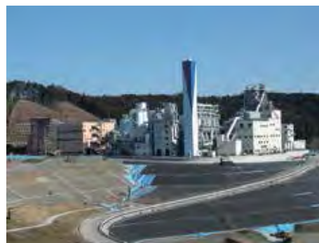
エコセメント施設の全景 提供：東京たま広域資源循環組合
