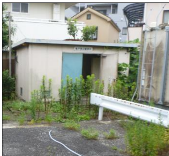
観測井の外観
