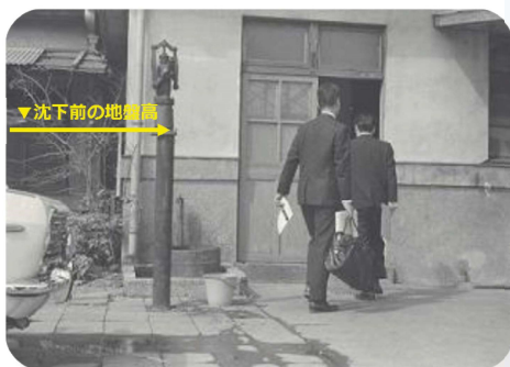
地盤沈下による井戸の抜け上がり (葛飾区、昭和30～40年代)
