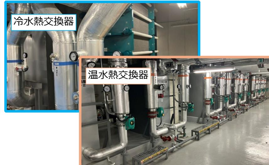
下水熱の有効利用により排熱による風の道を妨げない
