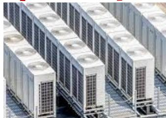
ビル別熱源の場合、屋上冷却塔から放熱、周囲温度が上昇し風の道を阻害してしまう
