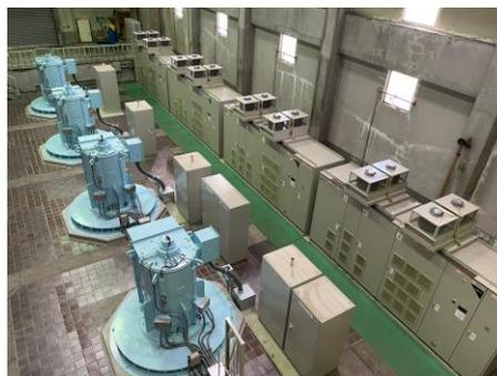
電動機、インバータ制御装置
