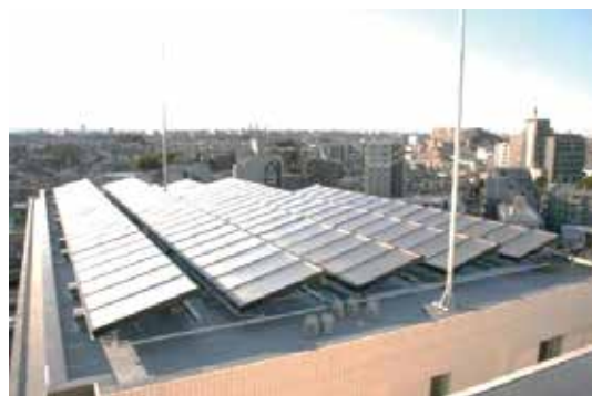
2重ガラスを使用した集熱性能の高い大型集熱器
