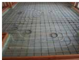
床暖房配管 (埋設前) 1F ほぼ全面に配管を施工
