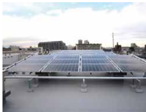
太陽光発電・太陽熱集熱器 一体型ハイブリッドパネル
