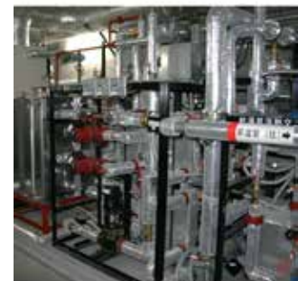
ソーラー熱回収装置
