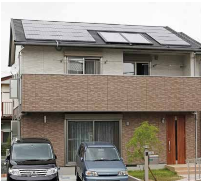
建物と屋根の集熱器（太陽熱は中央の2枚）
