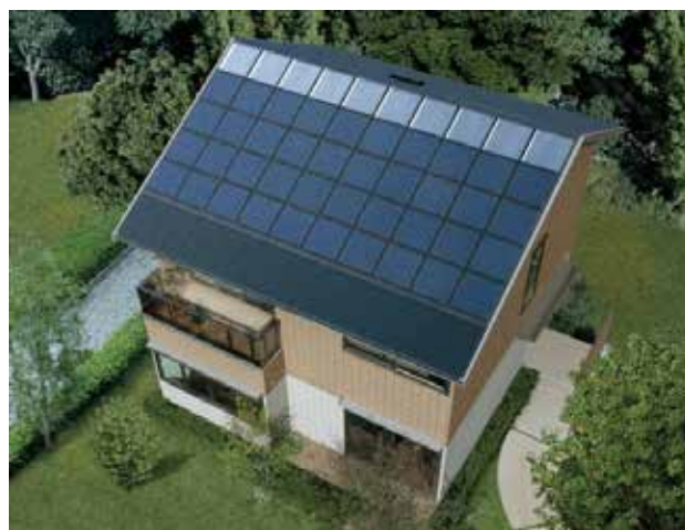
太陽熱ガラス集熱モジュールと太陽電池モジュール
