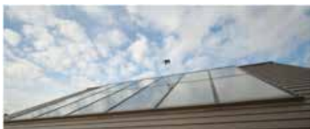
建材一体型太陽熱集熱器 瓦、金属葺きなど様々な屋根材に対応
