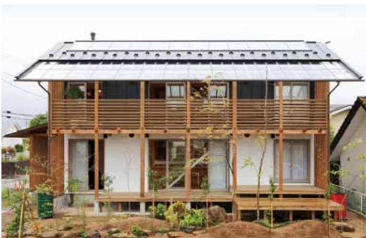
建物の外観と空気集熱器
