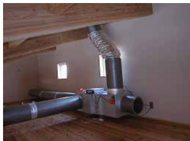
ハンドリングボックス(ハンドリングユニット)：集熱空気の進路をコントロールする。
