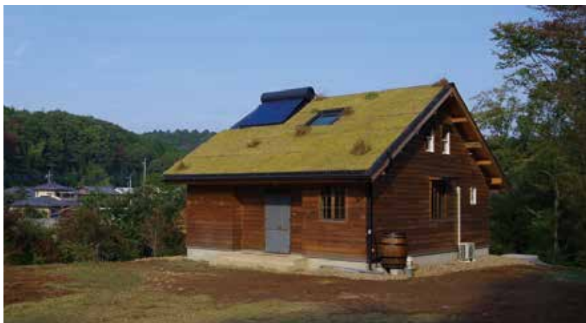
建物全景と太陽熱温水器
