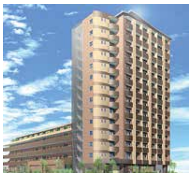
アーレア戸越公園の建物全景
