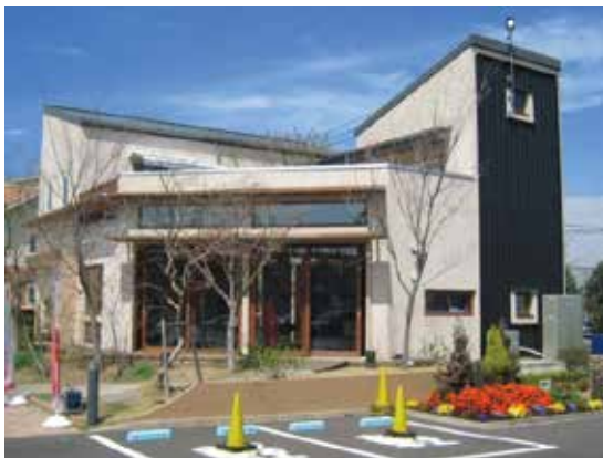
建物の壁に設置されたソーラーウォール
