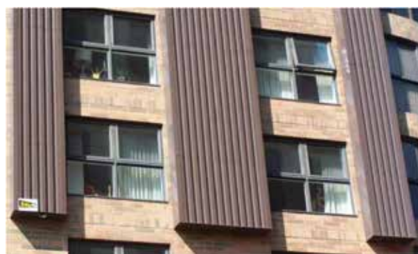
窓の間に取り付けられたソーラーウォール
