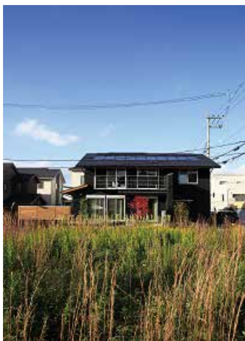
建物の外観と屋根の集熱器（撮影：上田明）
