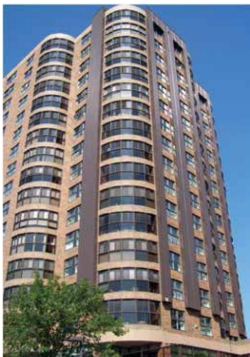
建物の全景とソーラーウォール
