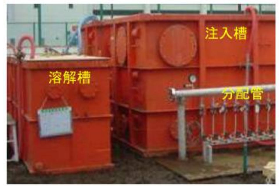
クロロクリン注入設備例
