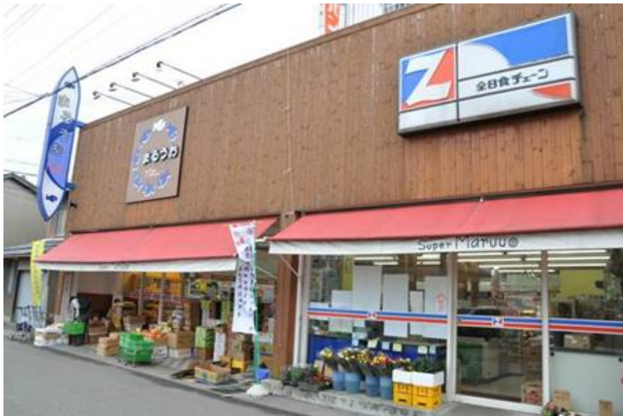
丸魚フードセンター全景
