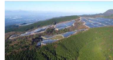
熊本県大津 30MW 太陽光
