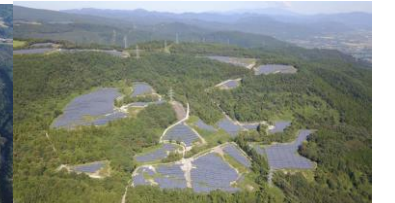
福島県あづま小富士 100MW 太陽光
