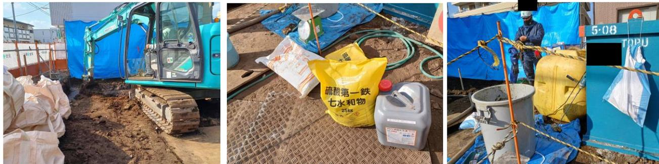
攪拌混合工事(バックホーによる掘削)
