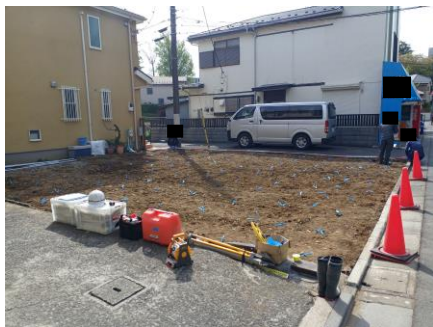
位置出し測量、とプラント設置(ミニクレーン使用) プラントは3m×9m程度で設置範囲としては最小に近い
