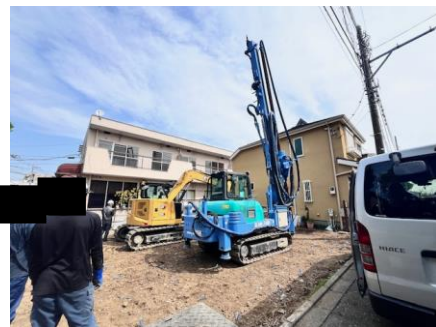
位置出し測量、とプラント設置(ミニクレーン使用) プラントは3m×9m程度で設置範囲としては最小に近い
