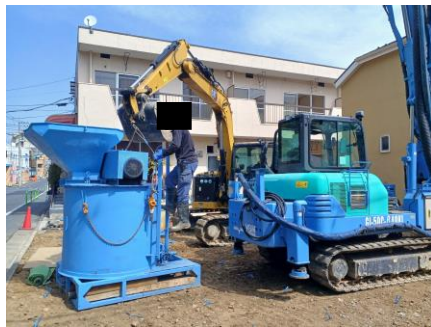
位置出し測量、とプラント設置(ミニクレーン使用) プラントは3m×9m程度で設置範囲としては最小に近い
