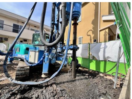
鉄粉攪拌工事(柱状噴射式攪拌混合機) 今回サイト：GL-5.0m
