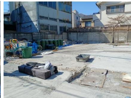
注入プラント設置（プラント面積：6×10m程度） ※今回サイトは材料も一括で搬入したため、材料置場で5×10m程度）
