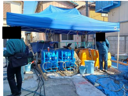
注入プラント設置（プラント面積：6×10m程度） ※今回サイトは材料も一括で搬入したため、材料置場で5×10m程度）
