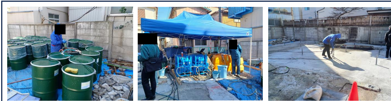
薬剤注入 プラントからホースで各井戸へ注入する。
