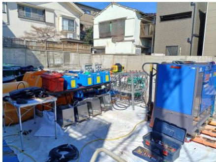
注入プラント設置（プラント面積：6×10m程度） ※今回サイトは材料も一括で搬入したため、材料置場で5×10m程度）
