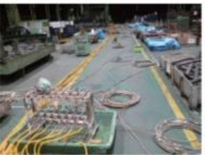
稼働工場内の土壌浄化の注入状況
