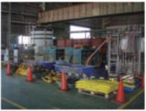
稼働工場内の注入プラント状況
