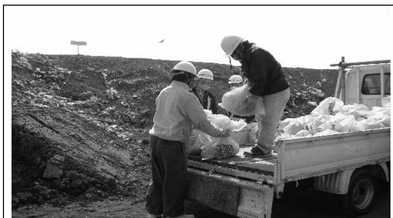
(参考) アスベスト廃棄物の搬入
