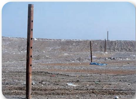
填埋后的废弃物会产生甲烷气体。为了不让甲烷气体引起火灾，要把排气管打进填埋地，进行排气。
