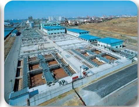
来自填埋处理场的渗出水在内侧填埋地的排水处理场通过各种方法进行净化处理。
