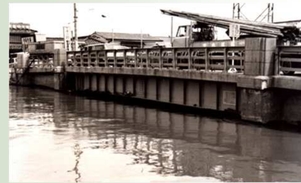
写真1：河川の両岸とともに橋が沈下し、船舶の航行が困難になった (昭和35年頃 綾瀬川)
