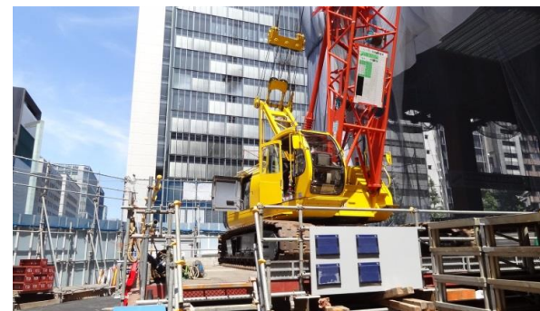
BDFを使用する重機
