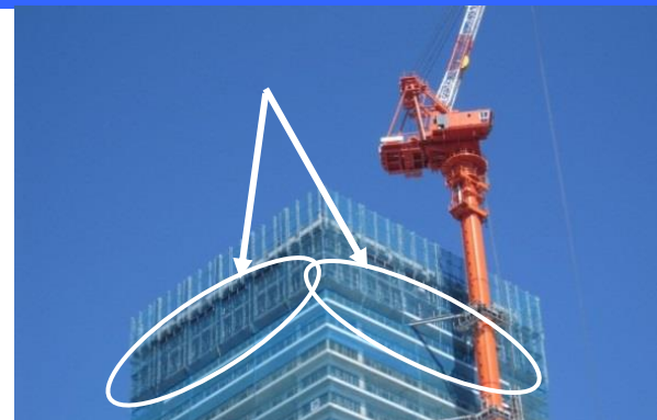
仮設太陽光発電パネル
