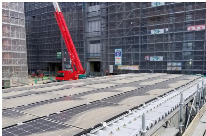
仮設事務所屋根に太陽光パネルを設置
