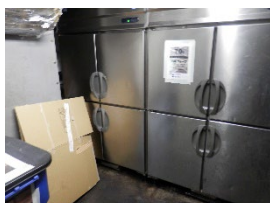
廃棄物保管庫（厨芥類）
