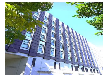
【参考】 建材一体型太陽光パネル （外壁用）の設置事例 （東京大学先端科学技術 研究センター）
