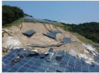
土砂崩れで生じた崩落
