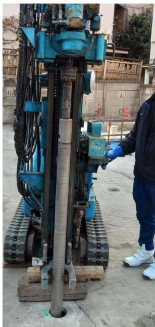
注入孔削孔 ケーシング設置
