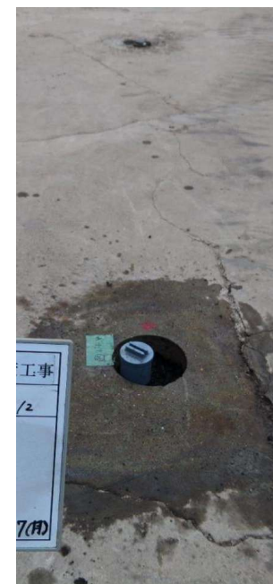
スリーブパイプ 設置完了
