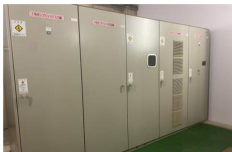
図2 配水ポンプ用インバータ装置
