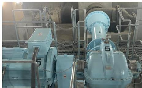
図1 配水ポンプ本体及び電動機
