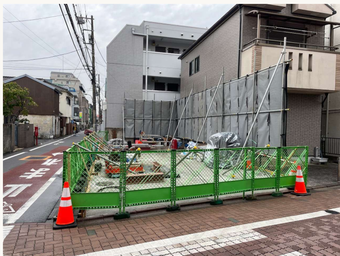
防音パネルの設置
