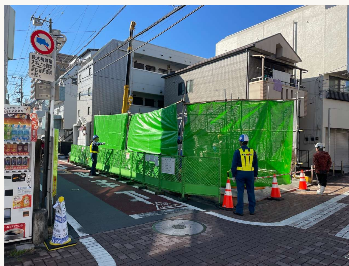
養生シートの設置
