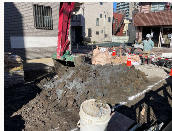
鉄粉攪拌混合状況
