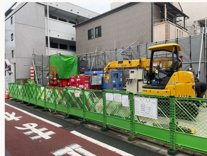
プラント機材搬入
