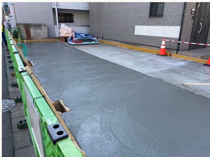
作業床の整備
