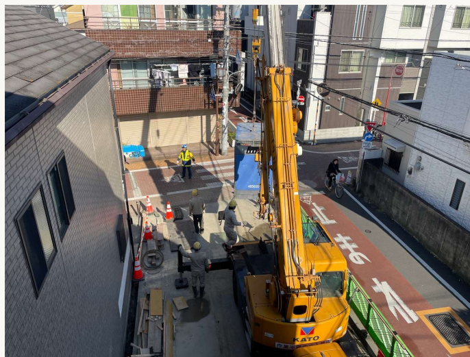
大型発電機搬入
