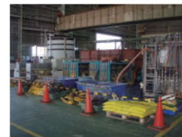
稼働工場内の注入プラント状況
