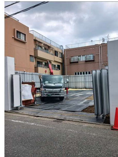
準備工（機材荷下ろし）
