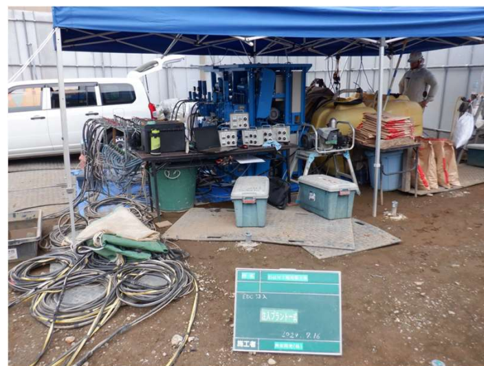
注入プラント完成
