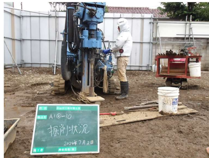
ボーリング削孔
