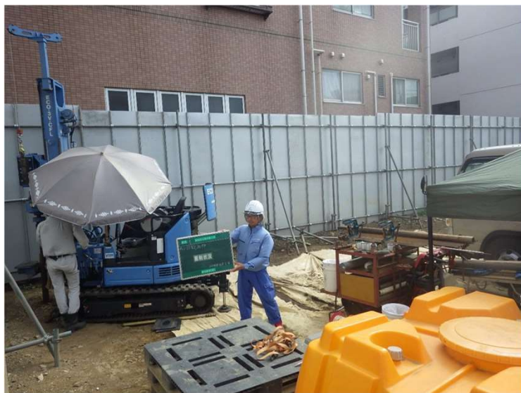
ボーリング削孔
