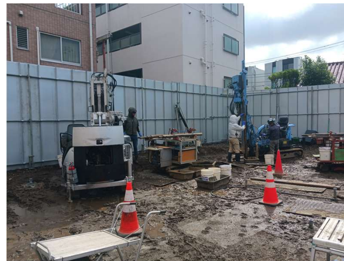
準備工（機材荷下ろし）
