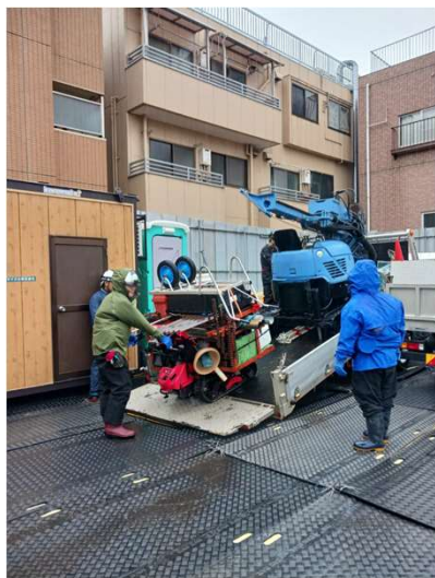
準備工（機材荷下ろし）
