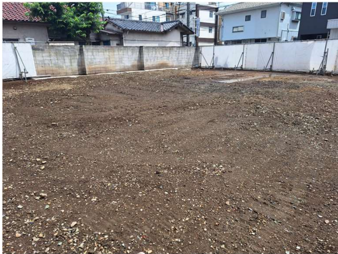
施工前（建造物解体後）
