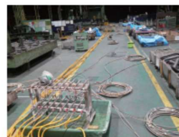
稼働工場内の土壌浄化の注入状況
