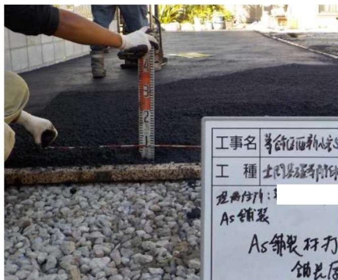
アスファルト舗装5cmで施工
