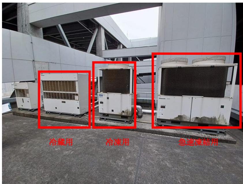
図 3-1 現場 A 冷凍機設置状況
