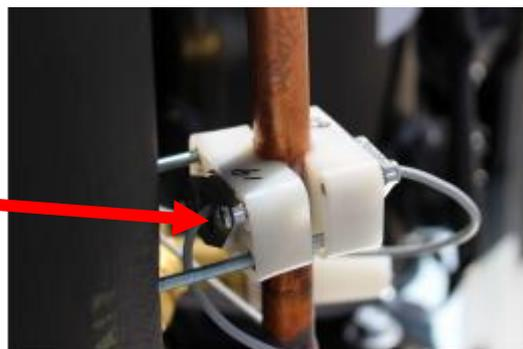
図 1-3 冷凍設備への超音波センサー設置イメージ
