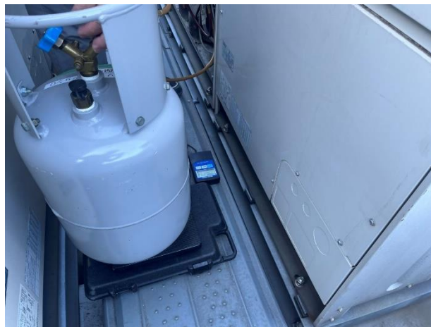
図 2. ビル用マルチエアコン 室外ユニットでの冷媒回収の状況
