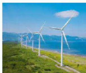
リエネ銭函風力発電所
