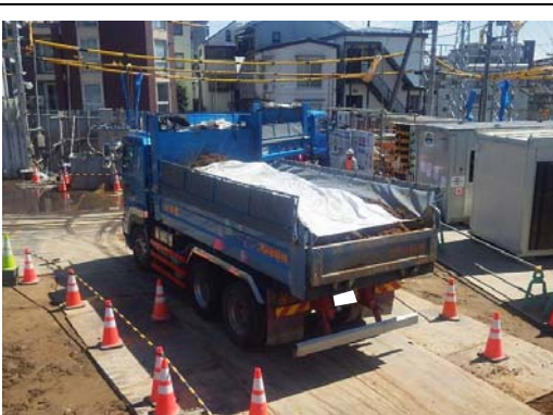
写真-5 荷台への防じんシート敷設の状況（地点03）
