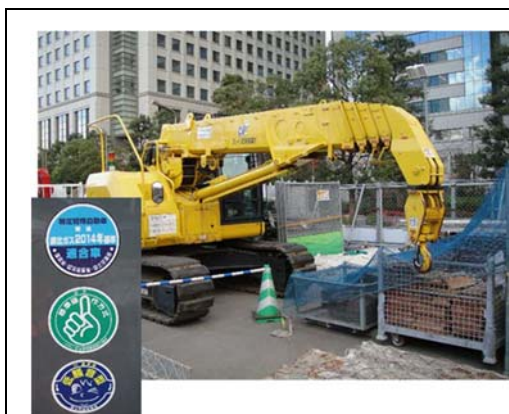
写真-1 排出ガス対策型建設機械の採用 （地点 01）
