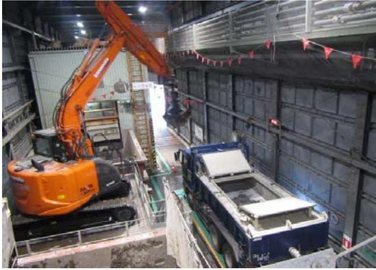
写真-1 建設汚泥の脱水処理の状況
