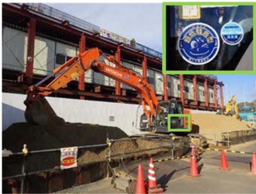
写真-5 低騒音型建設機械の採用（地点 02）
