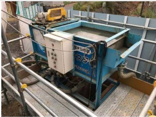
写真-3 濁水処理設備の設置状況（地点 02）
