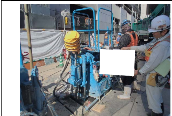
写真-3 薬液注入工の状況（地点 01）
