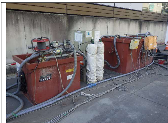
写真-1-1 工事排水の処理状況（地点 01）
