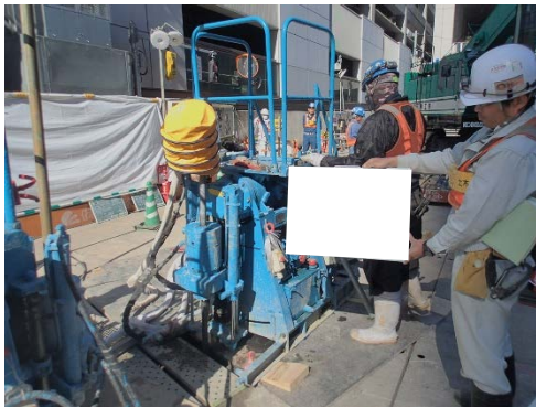
写真-2 薬液注入工の状況（地点 01）
