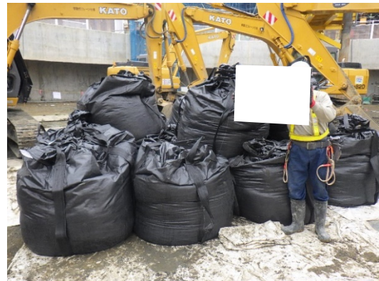
写真-3 発生土の仮置き状況（地点 02）
