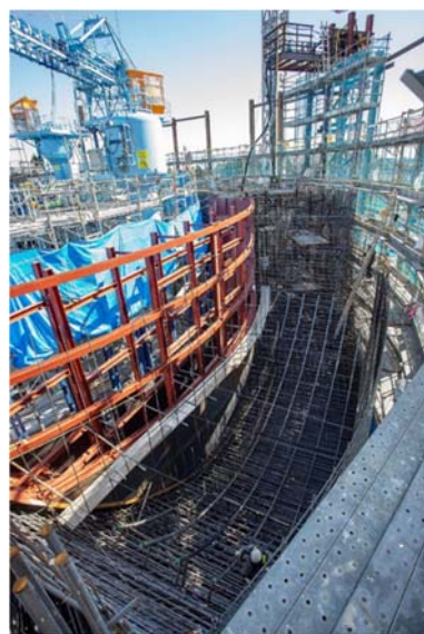
写真 3-4-8(2) 鉄筋組立の状況 (令和 3 年 3 月時点)
