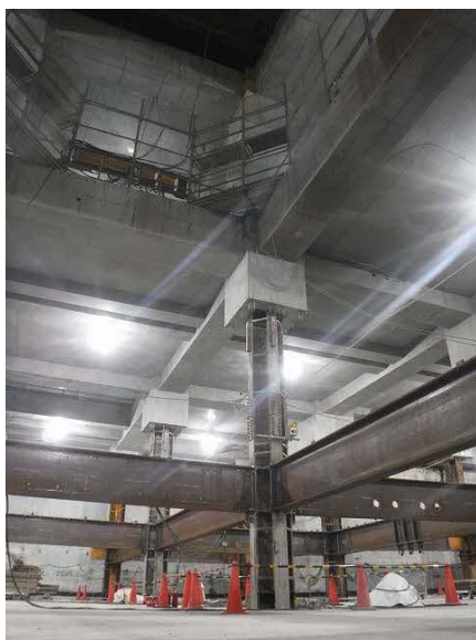
写真 3-4-4(1) 掘削・躯体構築状況 (令和 2 年 12 月時点)
