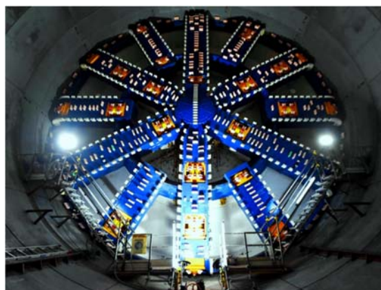
写真 3-4-3(2) 耐圧円筒内に据え付けられた シールド機の状況 (令和 3 年 3 月時点)
