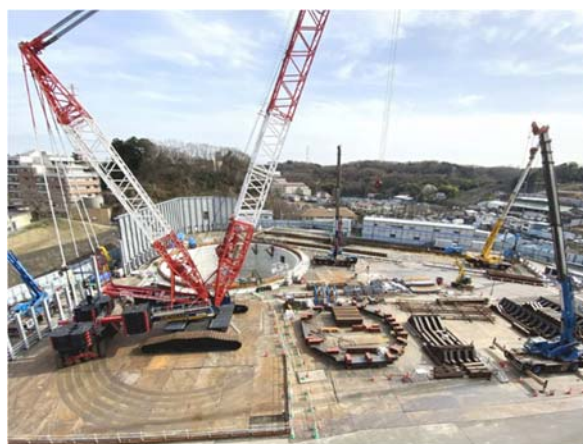
写真 3-4-7(2) 発進のための設備設置状況 （令和 3 年 3 月時点）
