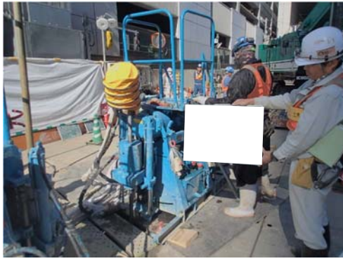
写真-8-1 薬液注入工の状況（地点 01）
