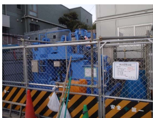
写真-6-2 工事排水の処理状況（地点 02）
