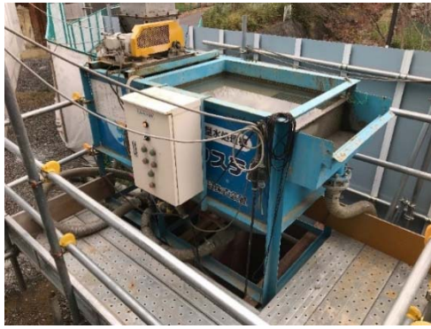
写真-9 工事排水の処理状況（地点 05）
