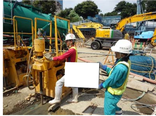
写真-8-2 薬液注入工の状況（地点 02）
