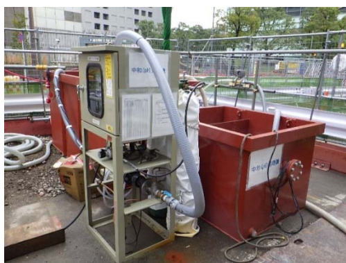
写真-6-1 工事排水の処理状況（地点 01）
