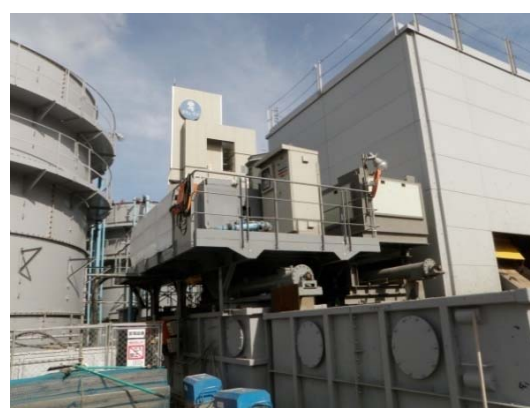
写真-1-2 建設汚泥の脱水処理の状況 (地点 02)
