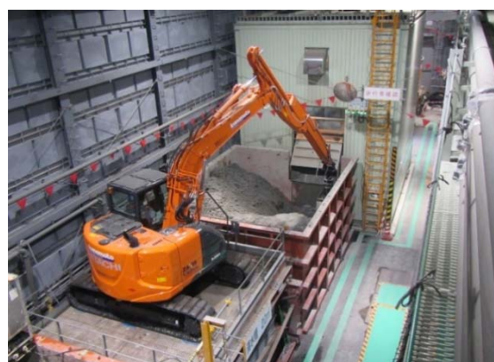
写真-1-1 建設汚泥の脱水処理の状況 (地点 01)
