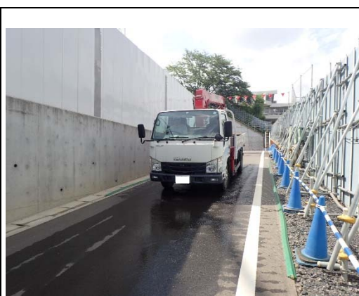
写真-2 タイヤの洗浄の状況（地点 02）
