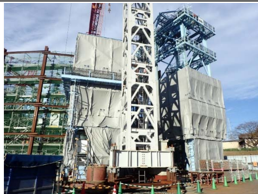
写真-4 防音シートの設置（地点 02）
