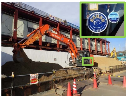
写真-5 超低騒音型建設機械の採用（地点 02）
