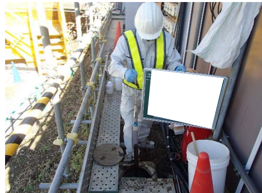
写真-1-2 地下水の監視状況（地点 02）
