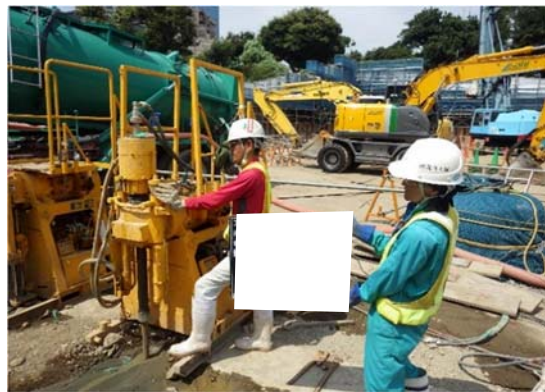
写真-2-2 薬液注入工の状況（地点 02）
