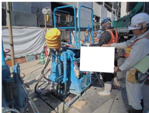
写真-2-1 薬液注入工の状況（地点 01）
