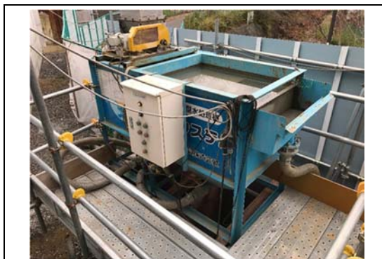
写真-1 工事排水の処理状況 (地点 05)
