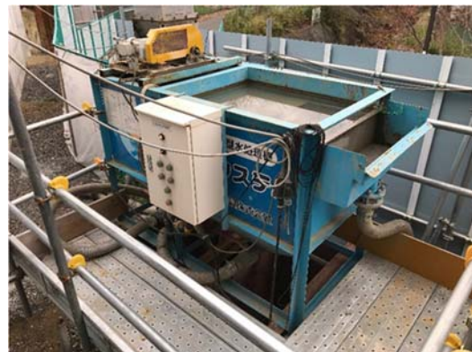
写真-1-2 工事排水の処理状況（地点 05）
