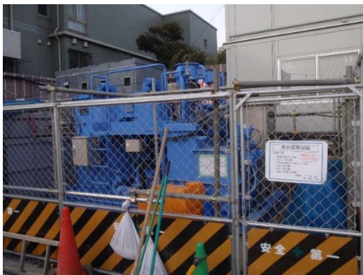
写真-1-1 工事排水の処理状況（地点 02）
