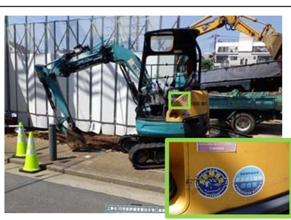
写真-1-2 排出ガス対策型建設機械の採用状況 (地点 03)
